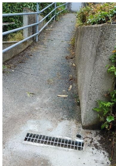
しみ出した水はグレーチングから溝に流れ排水されます。
